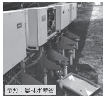
PCS内部部品破損・前面カバー落下状況
